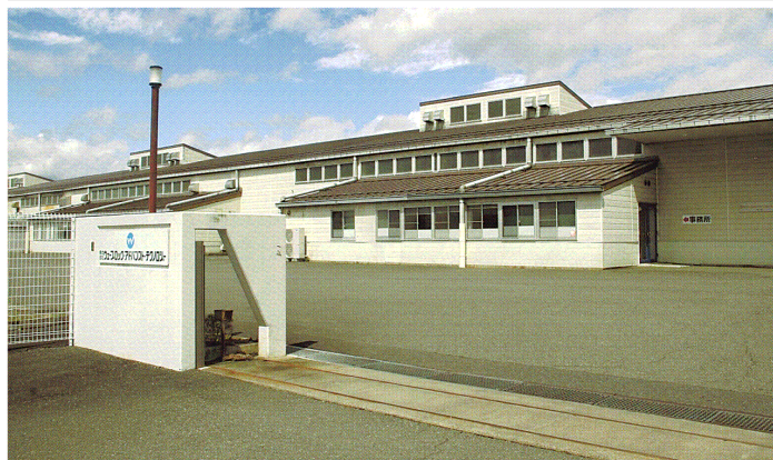
一関市東台地内に移転したウェーブロック・アドバンスト・テクノロジーの新工場
