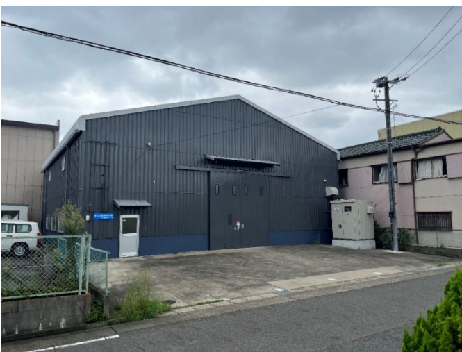
（照片=新设的名古屋第二工厂。负责使用金属风格装饰膜的汽车用塑料零件的真空成型、冲压工序）
